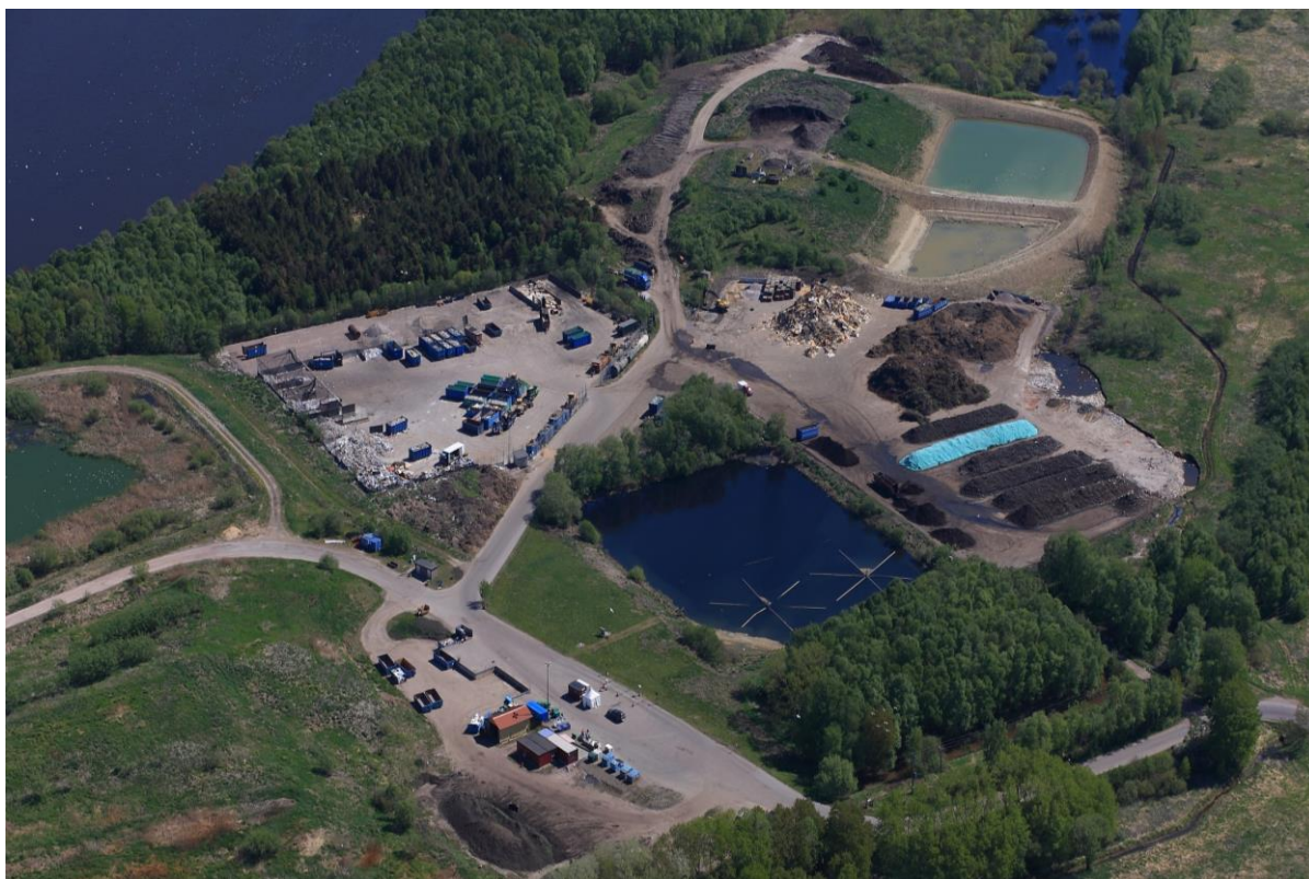
Bilden visar Rönneholms avfallsanläggning.
